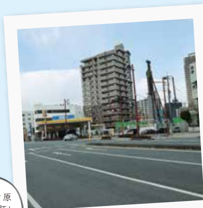
中央町交差点 JR久留米駅前を伸びる道は現在水害対策のため地下に貯水槽が建設されています。
